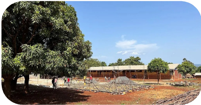
Bau eines Schulgebäudes
